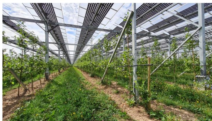
Die Leuchtstoffe sollen Anwendung in Solarmodulen für Agri-PV Installationen finden. Vorteile sind durch die Teilbeschattung weniger Verdunstung aber insbesondere durch die Lichtmodifikation, das Pflanzenwachstum zu beschleunigen. Daneben kann elektrische Energie gewonnen werden, was den Ertrag pro Flächeneinheit deutlich steigert.
